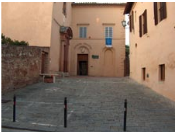
Figura 2 - Facciata della sede.
