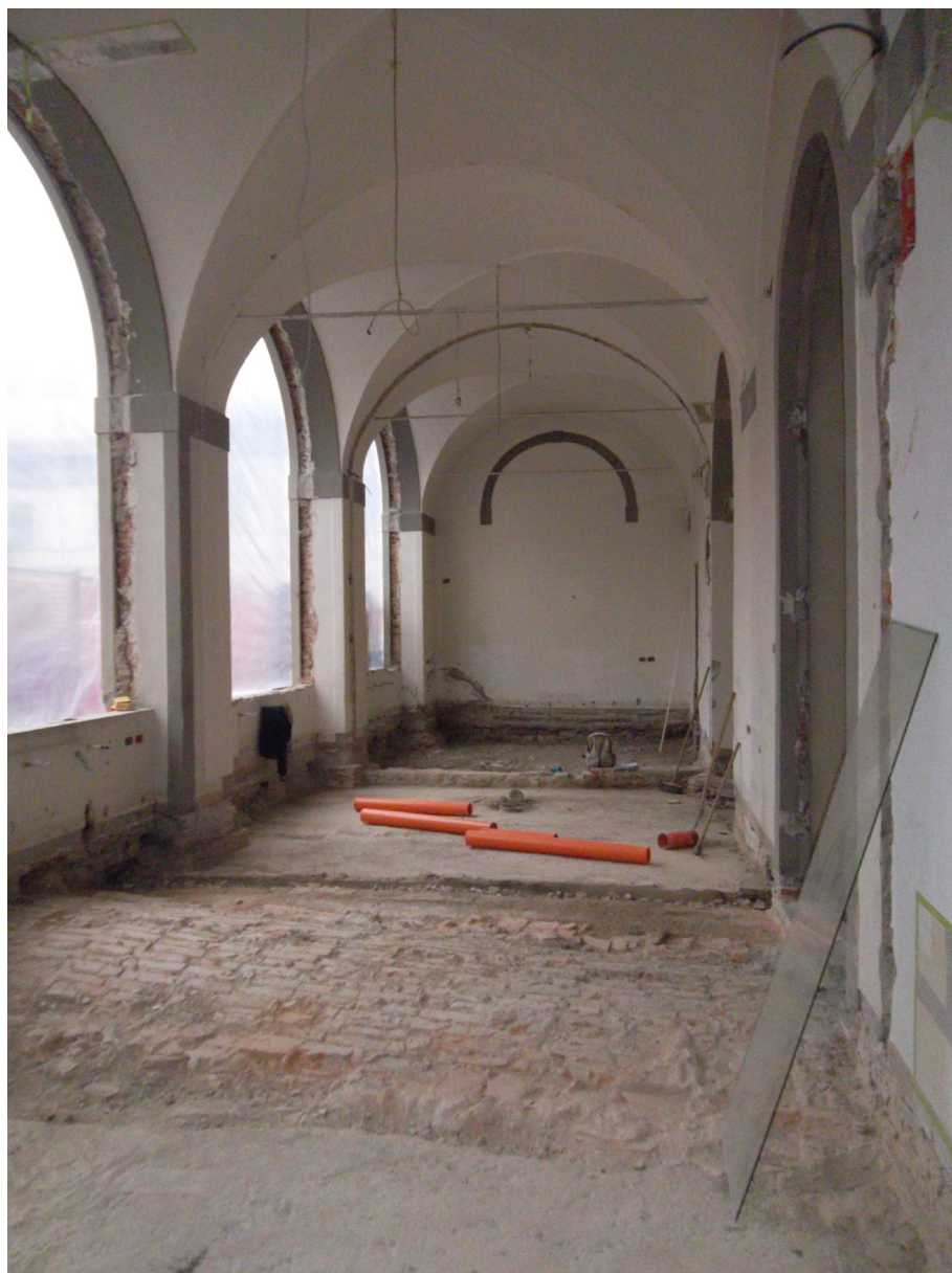
Figura 68: La loggia a grandi arcate (vani PT 20-21-22-23)
