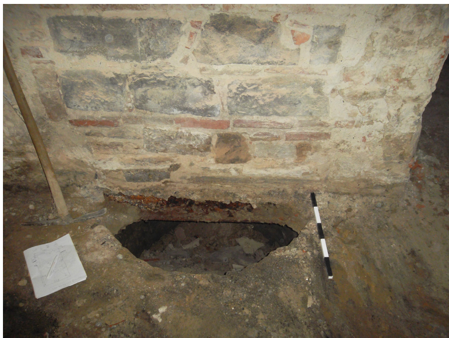
Figura 90: Il pozzo tra INT 7 e INT 6 (USM 43), in seguito intonacato
