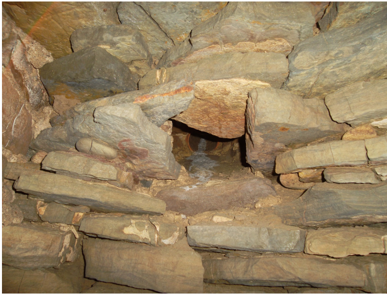
Figura 19: Tubo in cotto e connessa cassetta di adduzione sul versante occidentale della struttura a falsa cupola sotto PT 11, raccordo col sistema di raccolta e smaltimento delle acque piovane della turris
