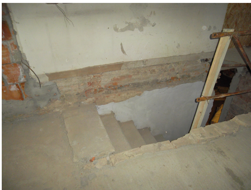
Figura 66: Scala rimessa in luce durante i lavori a Palazzo Cerretani, e che attualmente permette la discesa al percorso archeologico aperto al pubblico dopo gli scavi, nel 2018
