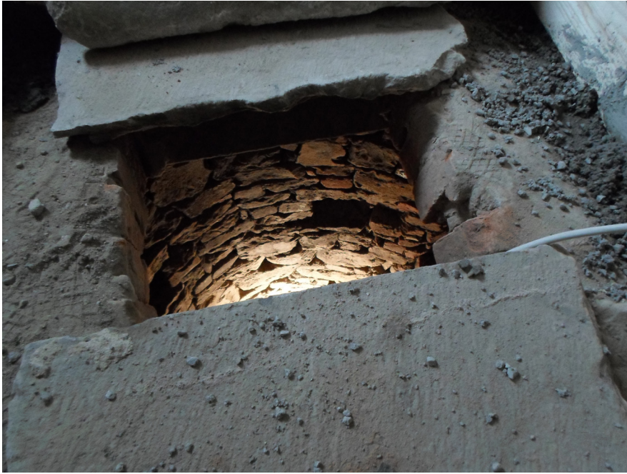
Figura 50: Pozzo collocato tra i vani PT 14 e 15 (USM 23) al momento della scoperta
