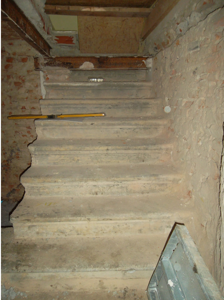
Figura 94: La scala che all'inizio dei lavori di ristrutturazione e delle indagini archeologiche da PT 26 scendeva in INT 13
