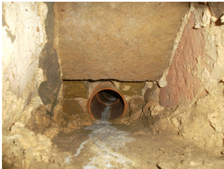
Figura 20: Tubo in cotto e connessa cassetta di adduzione sul versante occidentale della struttura a falsa cupola sotto PT 11, raccordo col sistema di raccolta e smaltimento delle acque piovane della turris
