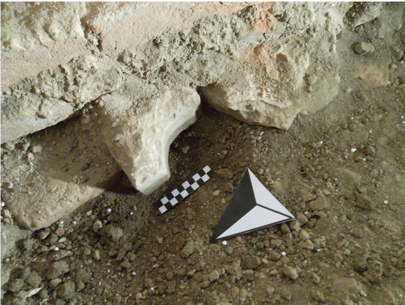
Figura 57: Particolare della mensola ad arco di foggia due-trecentesca
