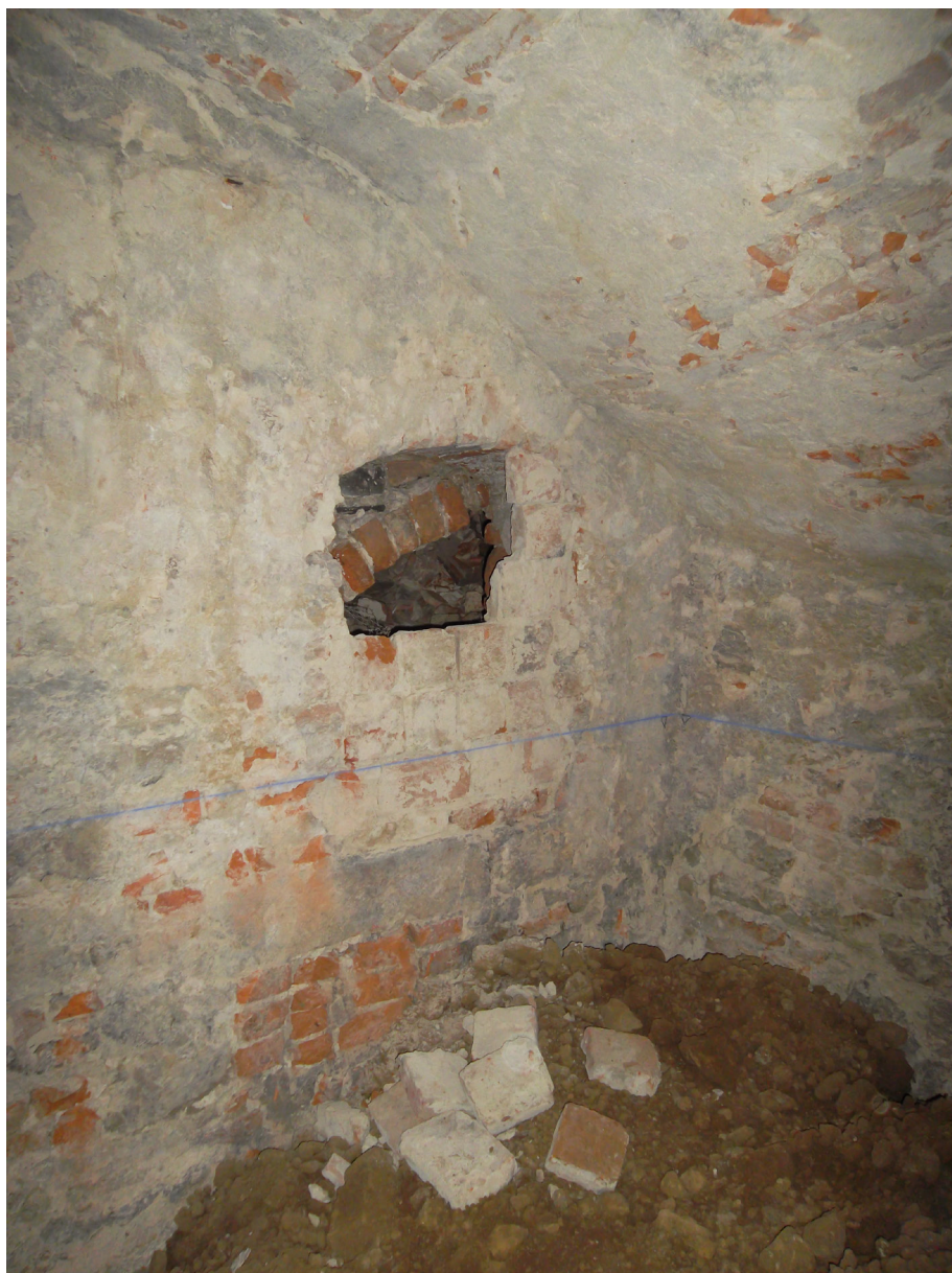
Figura 83: Accesso visivo ai resti di una possibile scala posta all'interno del tramezzo tra INT 16/18 ed INT 5
