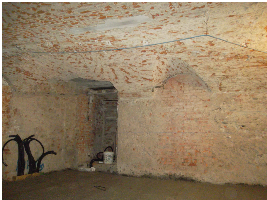
Figura 89: L'altro lato della porta, in INT 8, anche qui tamponata, corrispondente all'unghiatura nella volta
