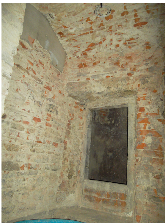
Figura 79: La modifica e lo sguancio di affaccio laterale al pozzo intonacato di INT 19, pozzo preesistente agli scantinati modificato non prima della creazione di INT 15 e della connessa scala di servizio
