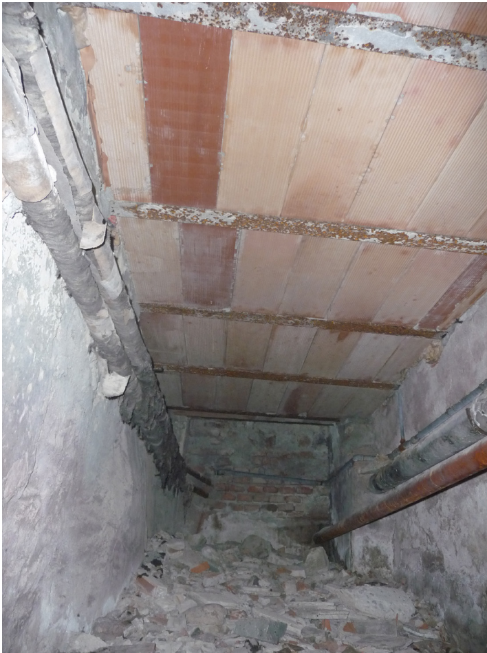
Figura 74: La rampa che, dipartentesi dal cortile interno posteriore del palazzo un tempo zona di orti, scende con un lungo tracciato di circa 8 m sino alla parte orientale della parete nord del vano INT 29
