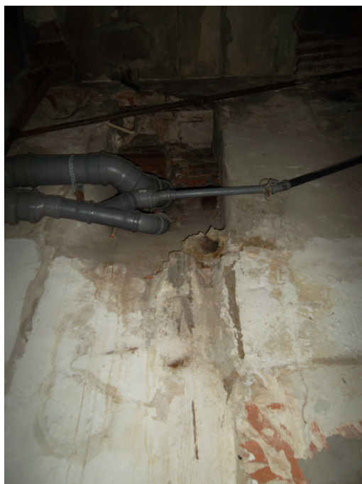
Figura 55: Conduzione di tiraggio di un camino, ricavata nello spessore della muraglia della parete est dell'ambiente PT 17
