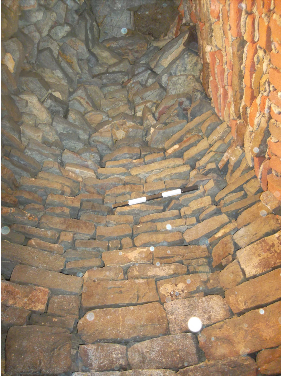
Figura 17: Costruzione sotterranea (USM 116) a falsa cupola a nord di INT 23
