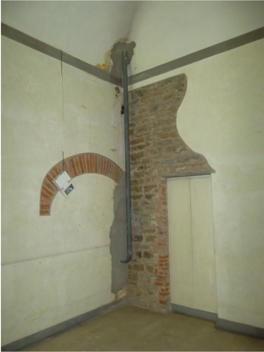
Figura 45: Arco di aspetto falcato in mattoni nella parete sud del vano PT 11, verso l'angolo occidentale
