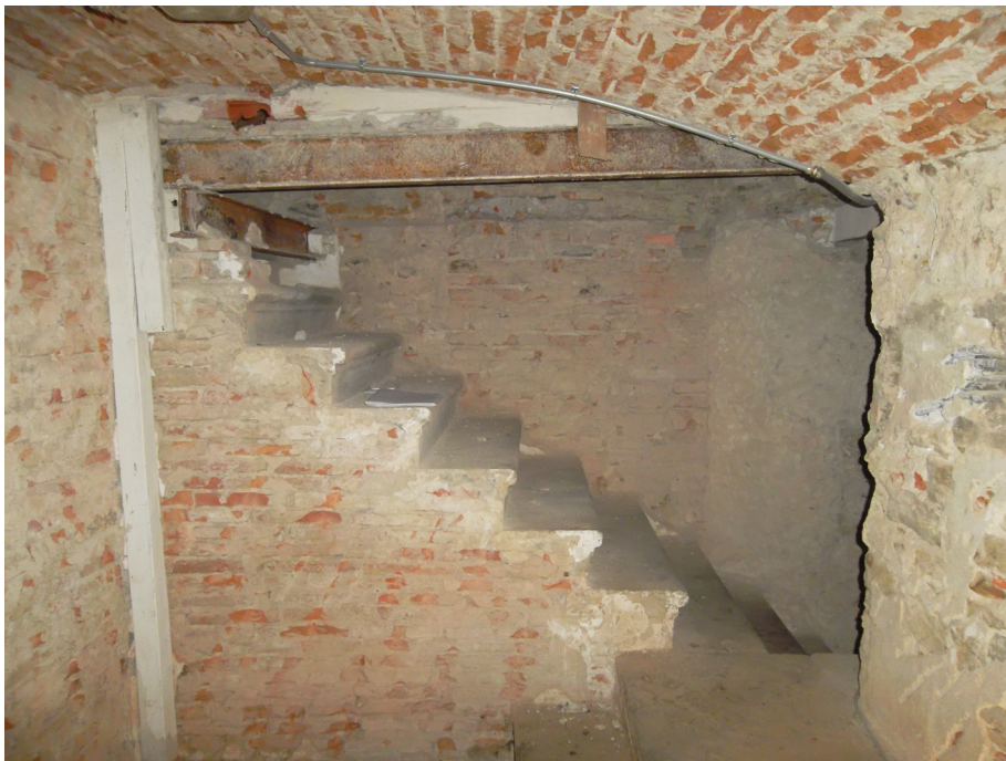
Figura 88: Sullo sfondo al centro, di là dalla scala, la traccia di una porta oggi tamponata posta all'angolo sud ovest dell'ambiente INT 13
