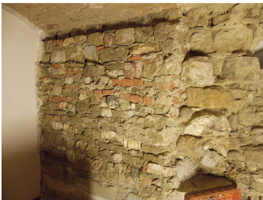
Figura 39: Nuova muratura parallela USM 78 eretta sotto PT 27
