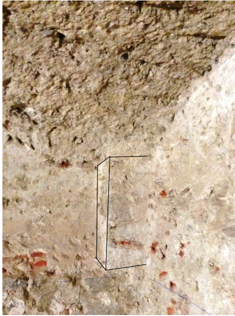
Figura 30: Pietra con nastrino liscio da scalpello, e superficie percorsa da fitte linee sottili e parallele di gradina, nell'angolo nord-ovest del vano INT 2/3, impostata sul filo esterno della risega di fondazione della parete orientale della turris
