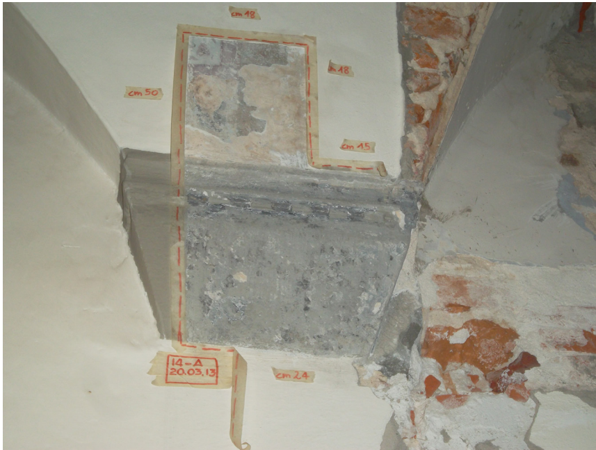
Figura 64: Peduccio a dentelli nella loggia angolare di PT 14 eretta in questa fase
