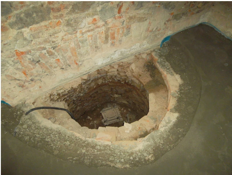
Figura 47: Bordatura di ripiano in mattoni messa in opera attorno alla bocca di un preesistente pozzo (USM 71) in piccole bozzette di pietra nel quadrante sudoccidentale di INT 24/25
