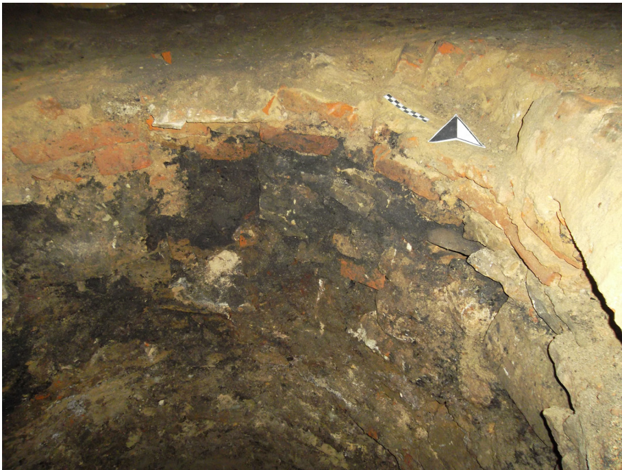
Figura 82: Sistemazione del pozzo circolare più settentrionale di INT 5, rasato e coperto con una fila di mattoni per piano
