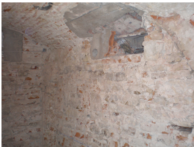
Figura 78: La parete orientale con archi di INT 15, con al centro, in alto, un abbaino per presa d'aria e di luce poi tamponato da murature più tarde
