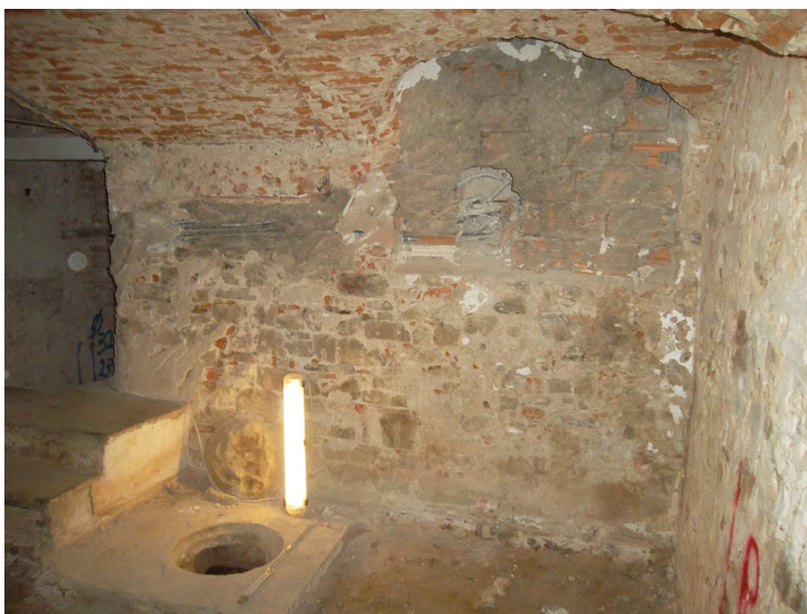
Figura 91: Il vano INT 13 ed, alla parete ovest verso la sua estremità settentrionale, la tamponatura di una finestra-abbaino con labbro spiovente verso la cantina, sguanci e sporti con battenti
