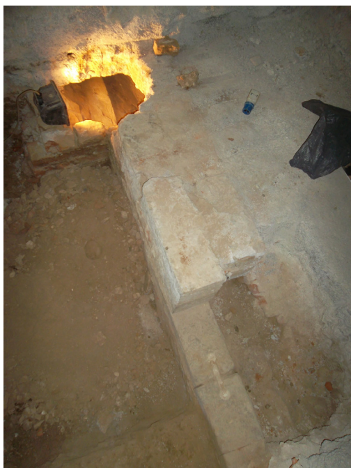
Figura 43: A servizio della cantina INT 23 venne messo in opera un abbaino nella sua parete nord (USM 129) con fori d'inferriata per presa d'aria e di luce, a sfociare su un'apertura appositamente praticata adesso nella facciata settentrionale della turris e messa in luce nel saggio nel vano PT 11 -nell'immagine-
